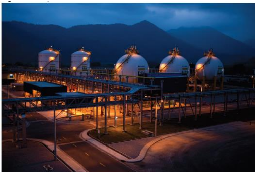
Figura IV: Parque de esferas de armazenamento de GLP em refinaria da Petrobras
